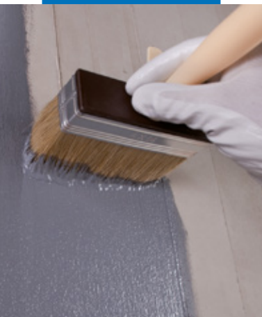
Applicazione di Eco Prim Grip con pennellina su supporto in calcestruzzo
