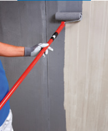
Applicazione di Eco Prim Grip a rullo su supporto in calcestruzzo
