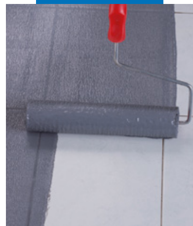
Applicazione a rullo di Eco Prim Grip su pavimento preesistente in piastrelle di gres porcellanato
