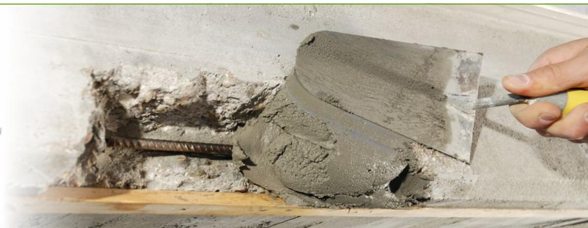
I limiti tecnici e prestazionali delle comuni malte a base di cemento e additivi chimici e dei complessi sistemi stratificati per il recupero del calcestruzzo sono oggi superati da GeoLite®, la rivoluzionaria geomalta® minerale eco-compatibile, che passiva, ripristina, rasa e protegge in un'unica soluzione il calcestruzzo ammalorato. Risultato: ripristini naturalmente stabili che si cristallizzano al calcestruzzo in un monolite dalla durabilità tipica di una roccia minerale.
