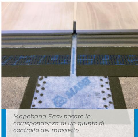
*Mapeband Easy posato in corrispondenza di un giunto di controllo del massetto*
